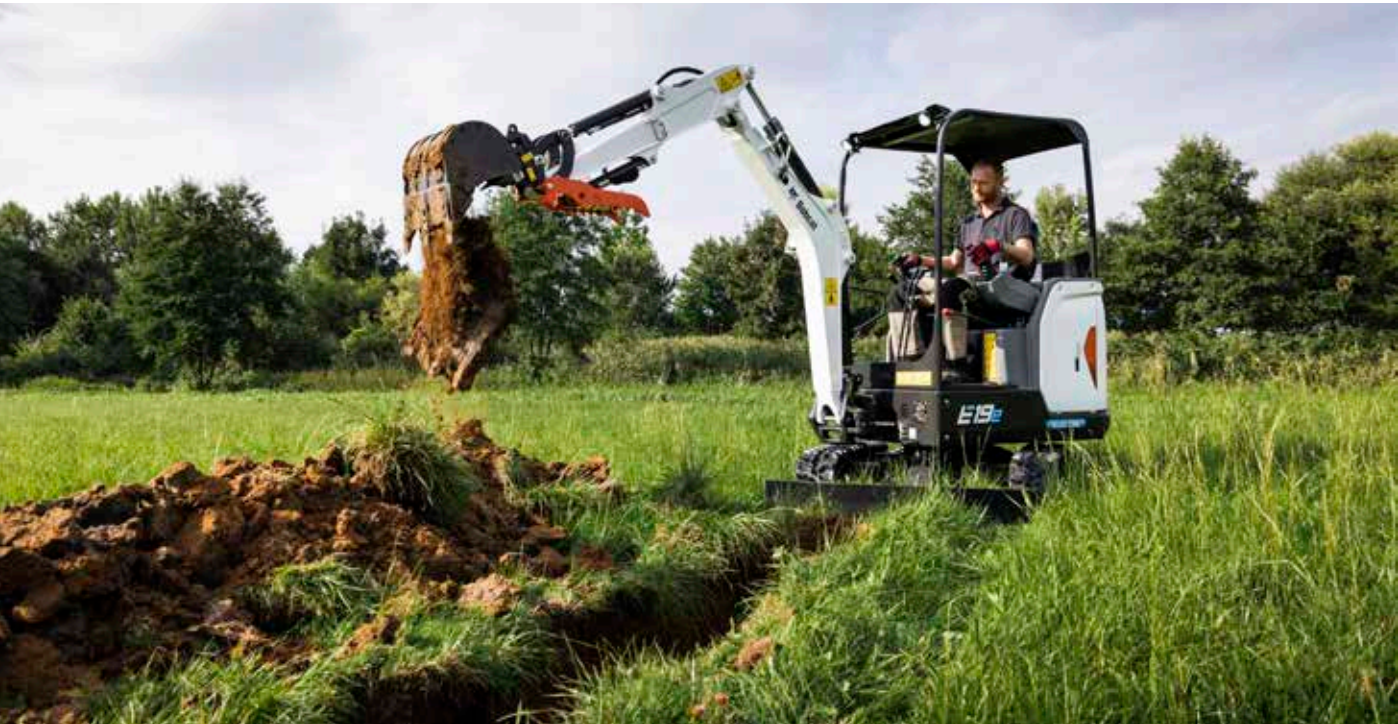
Creación de zanjas con la E19e
