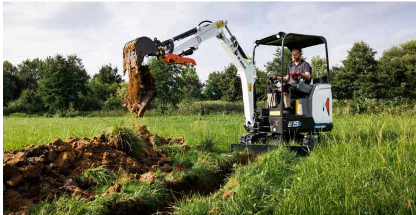
Creusement de tranchée avec l'E19e
