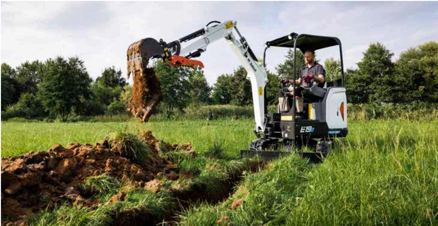
Scavo di canali con l'E19e
