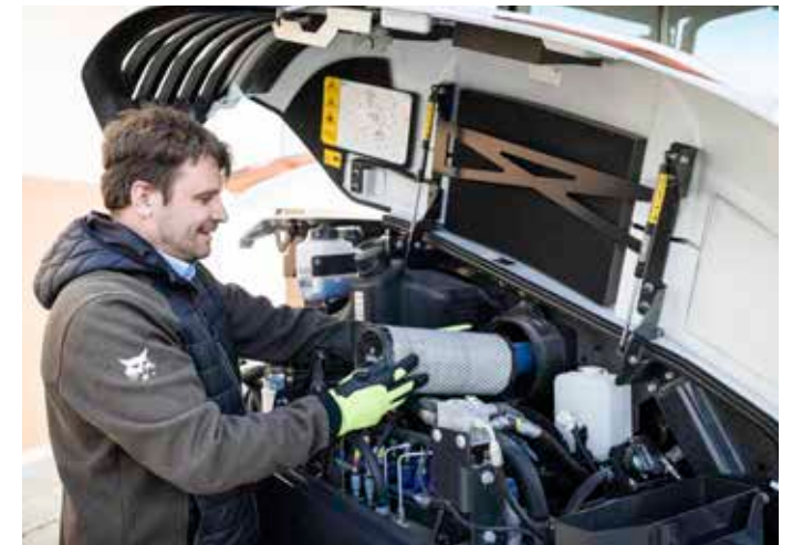
Remplacement des filtres
